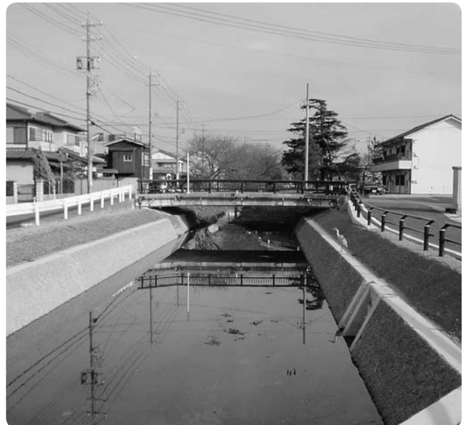
完成した護岸(準用河川船江川支川)
