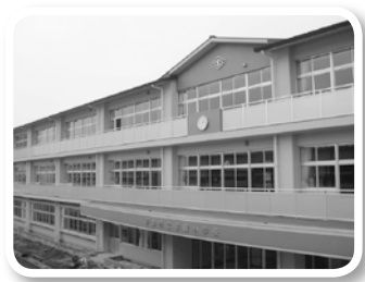
有緝小学校の新校舎
