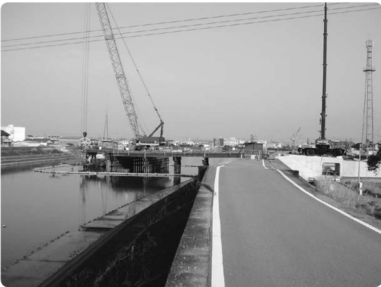
施工中の橋脚工事(市道大湊川線)
