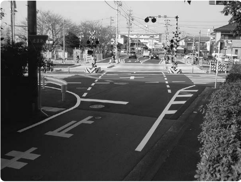
完成した掛橋踏切(市道小俣19号線)
