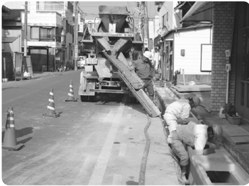
道路側溝の改良工事
